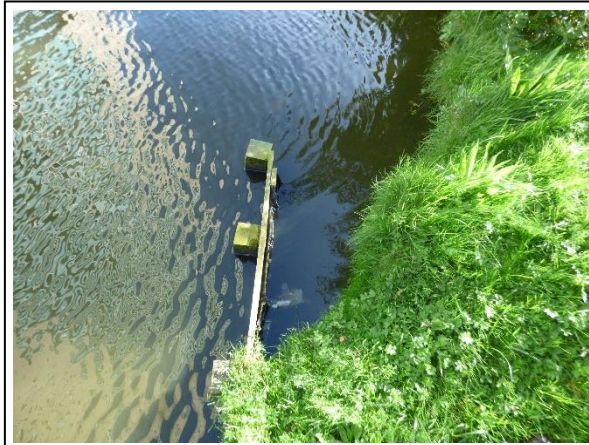
Foto 8 ontbrekende beschoeiing
