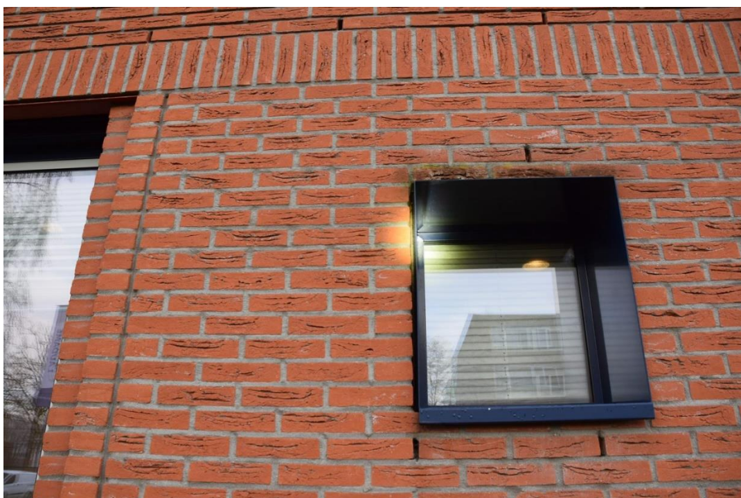
10 Open stootvoegen en ruimte langs het raamkozijn die toegang bieden tot de spouwmuur.
