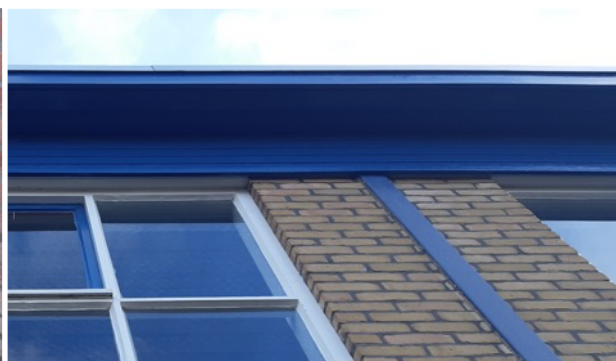
Afbeelding 18: Geen kieren in houten boeidelen.
