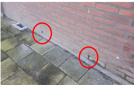
Afbeelding 17: Geen geschikte open stootvoegen.
