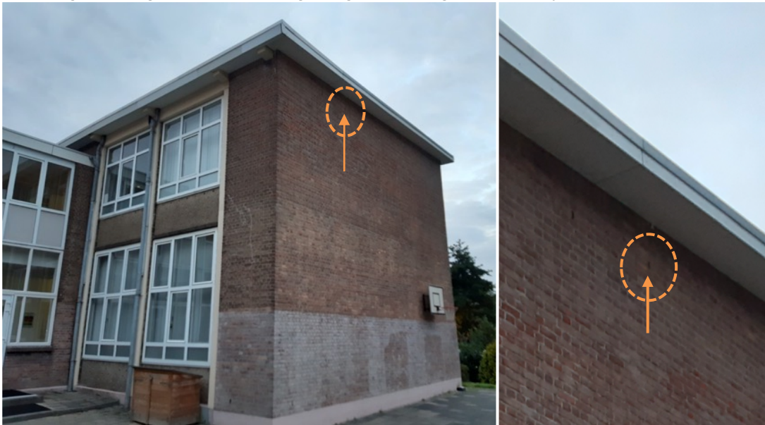
Afbeelding 3. Kopse gevel A, locatie invliegende gewone dwergvleermuizen 7 juli 2020
