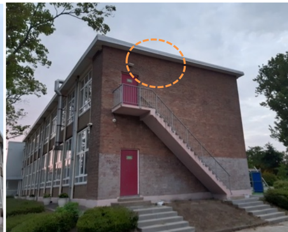
Afbeelding 5. Kopse gevel C
