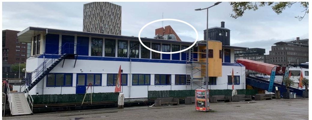
Figuur 10 Restaurant Zwarte Zwaan, uitblaas van keukenafzuiging (bron: dBvision)
