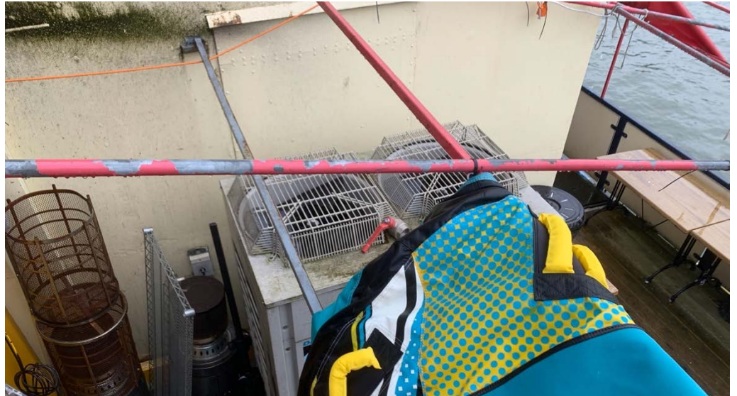
Figuur 12 Restaurant Zwarte Zwaan, inverters behorende bij luchttoevoer (bron: dBvision)
