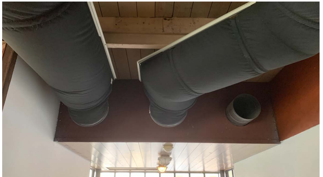
Figuur 11 Restaurant Zwarte Zwaan, luchttoevoer (bron: dBvision)
