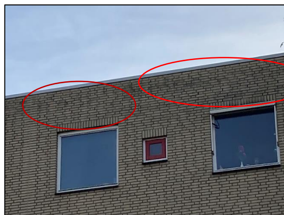
Figuur 34 Bebouwing Humanitas met open stootvoegen (rood omcirkeld)
