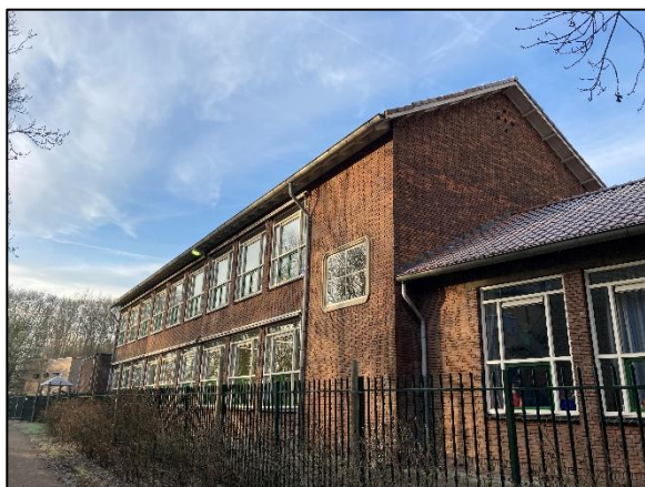
Figuur 23 Westzijde Elizabethschool met dakpannen en ruimte onder de dakgoot.
