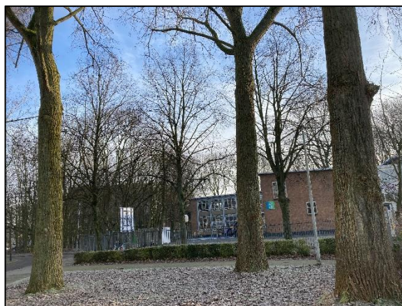
Figuur 8 Te slopen bebouwing van De Kameleon met schoolplein en bomengroep. Kijkrichting oost.
