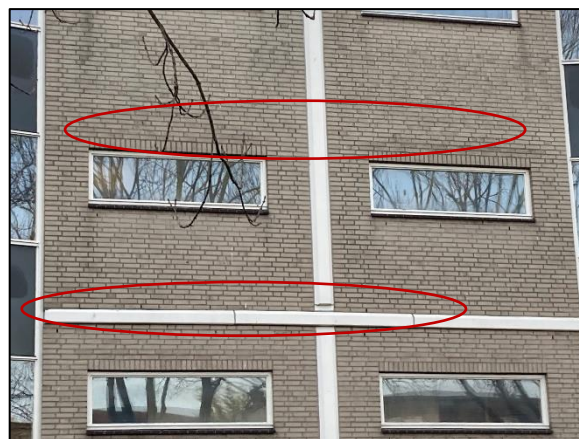
Figuur 36 Gevels aan de waterzijde van de bebouwing aan de noordzijde van het plangebied met open stootvoegen (rood omcirkeld).
