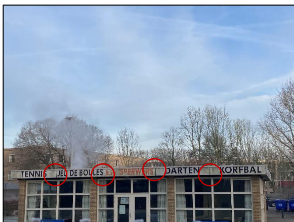
Figuur 33 Sportkantine met ruimte tussen beplating (rood omcirkeld)
