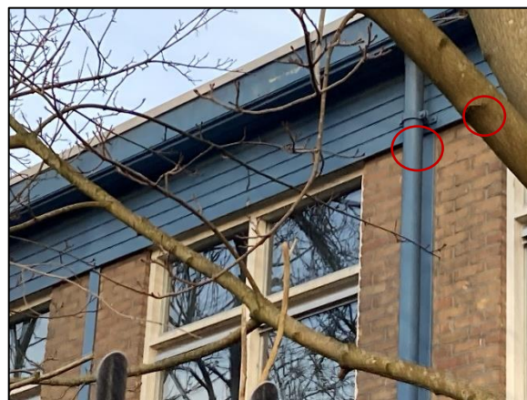
Figuur 32 Te slopen bebouwing van de Kameleon met mogelijk ruimtes achter beplating (rood omcirkeld).
