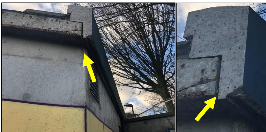
Figuur 2. Te slopen kelder. Geschikte ruimte voor vleermuizen.
