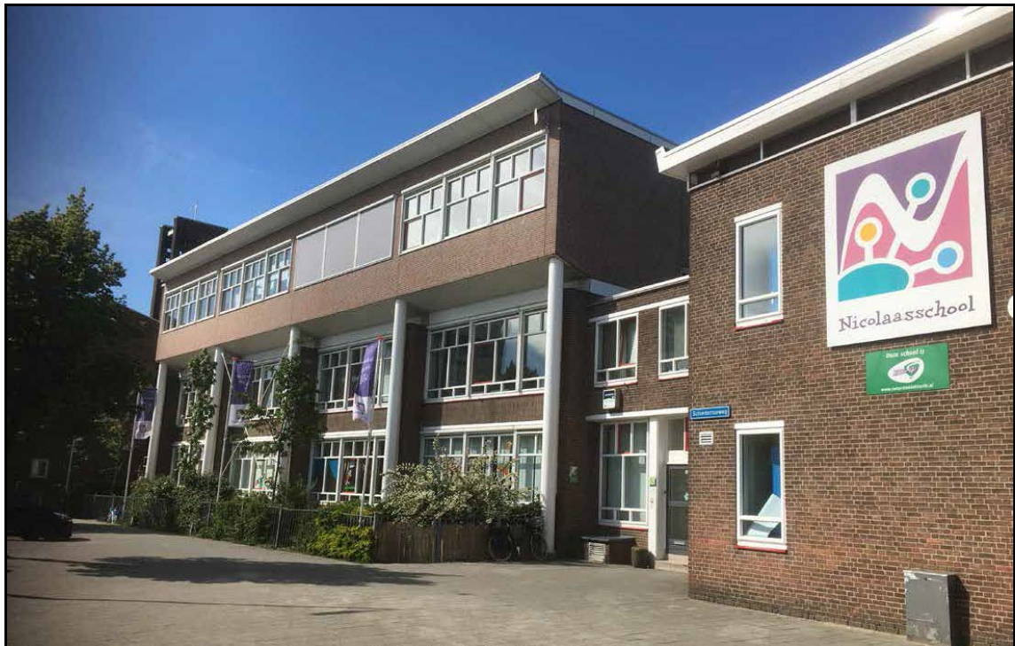
Afbeelding 4: Beeld van het bestaande schoolgebouw op de planlocatie.
