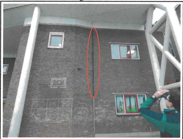
Foto 23: kier tussen de gevels
