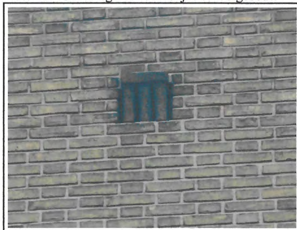
Foto 16: ventilatiegaten noordelijke schoolgebouw
