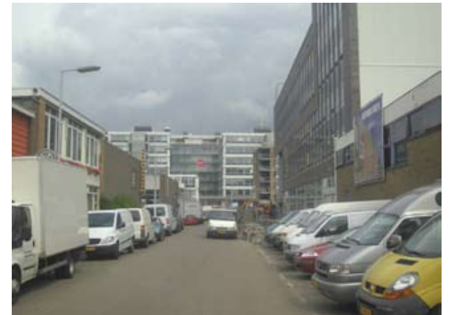
uitstraling openbare ruimte is hard en laagwaardig
