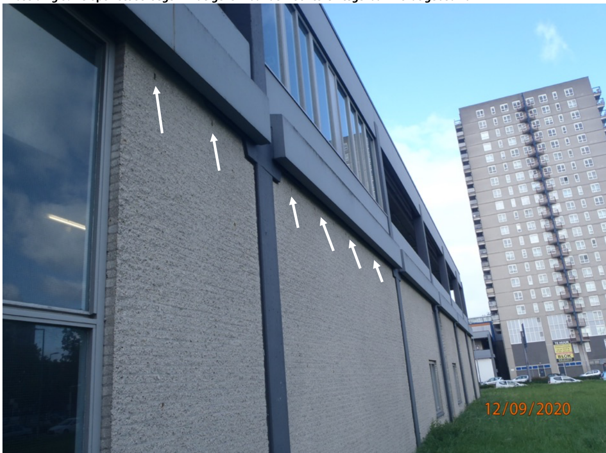
Afbeelding 9: De open stootvoegen in de gevel waar de woontoren tegenaan wordt gebouwd
