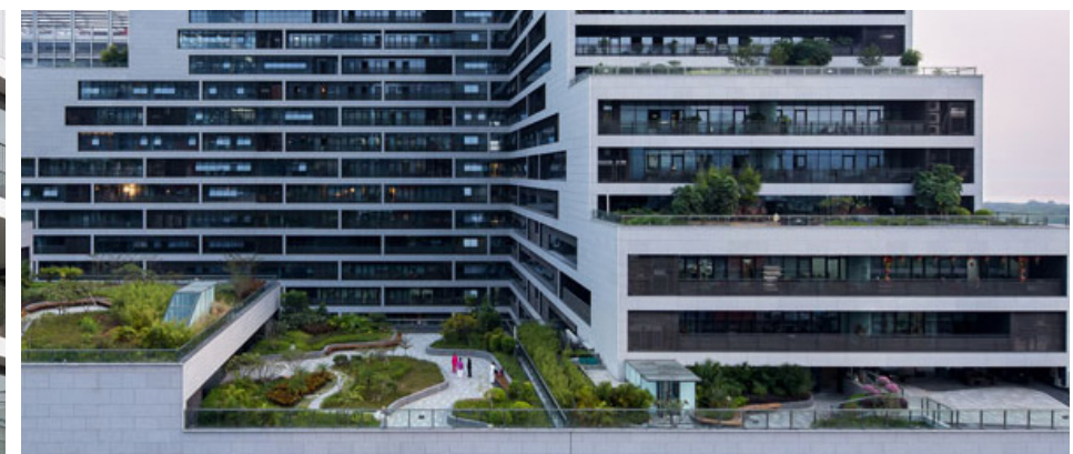
WONEN AAN DAKTERRASSEN
