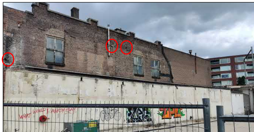
Figuur: de zuidgevel van het gebouw heeft diverse openingen in de muur (rode cirkels) waar vleermuizen kunnen invliegen en verblijfplaatsen kunnen hebben.
