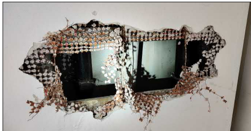
Figuur: er zijn diverse openingen in de muren van het gebouw. Vleermuizen kunnen hier invliegen en verblijfplaatsen hebben in de spouw.
