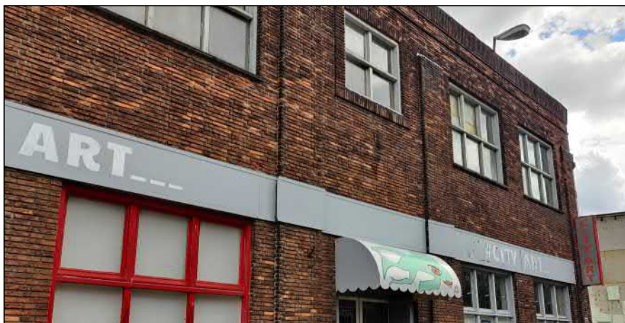
Figuur: de westgevel van het gebouw heeft geen geschikte invliegopeningen voor vleermuizen, huismus of gierzwaluw. Er is geen ruimte achter de grijze reclameborden.
