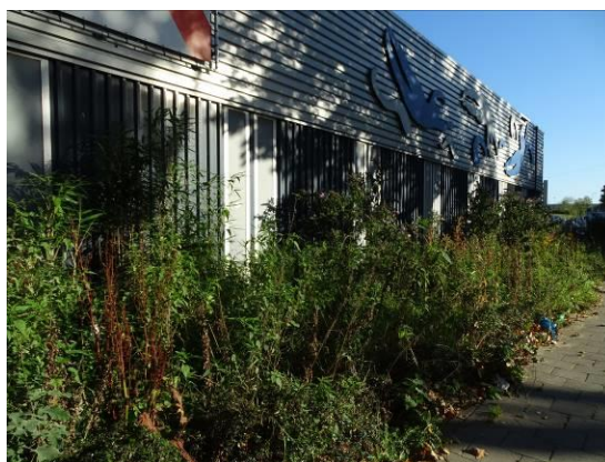
d) Zwembad blok B2 vanaf de Zuidzijde
