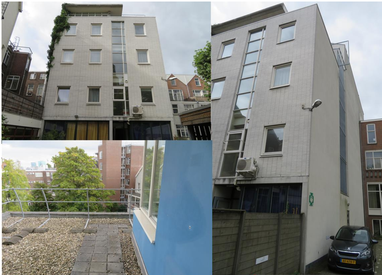
Foto-impressie plangebied: achtergevel, zijgevel en vijfde verdieping.
