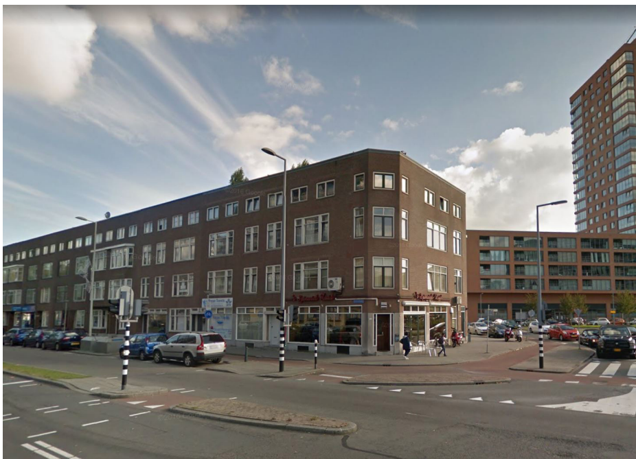
Referentie naastgelegen bebouwing - 4 lagen, donkerbruine baksteen
