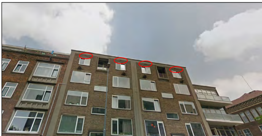
Figuur: in de omliggende bebouwing zijn vleermuisverblijfplaatsen mogelijk in spleten en kieren, zoals hierboven in de ventilatiegaten (rode cirkels).
