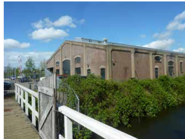
Gebouw Stoom Stichting Nederland
