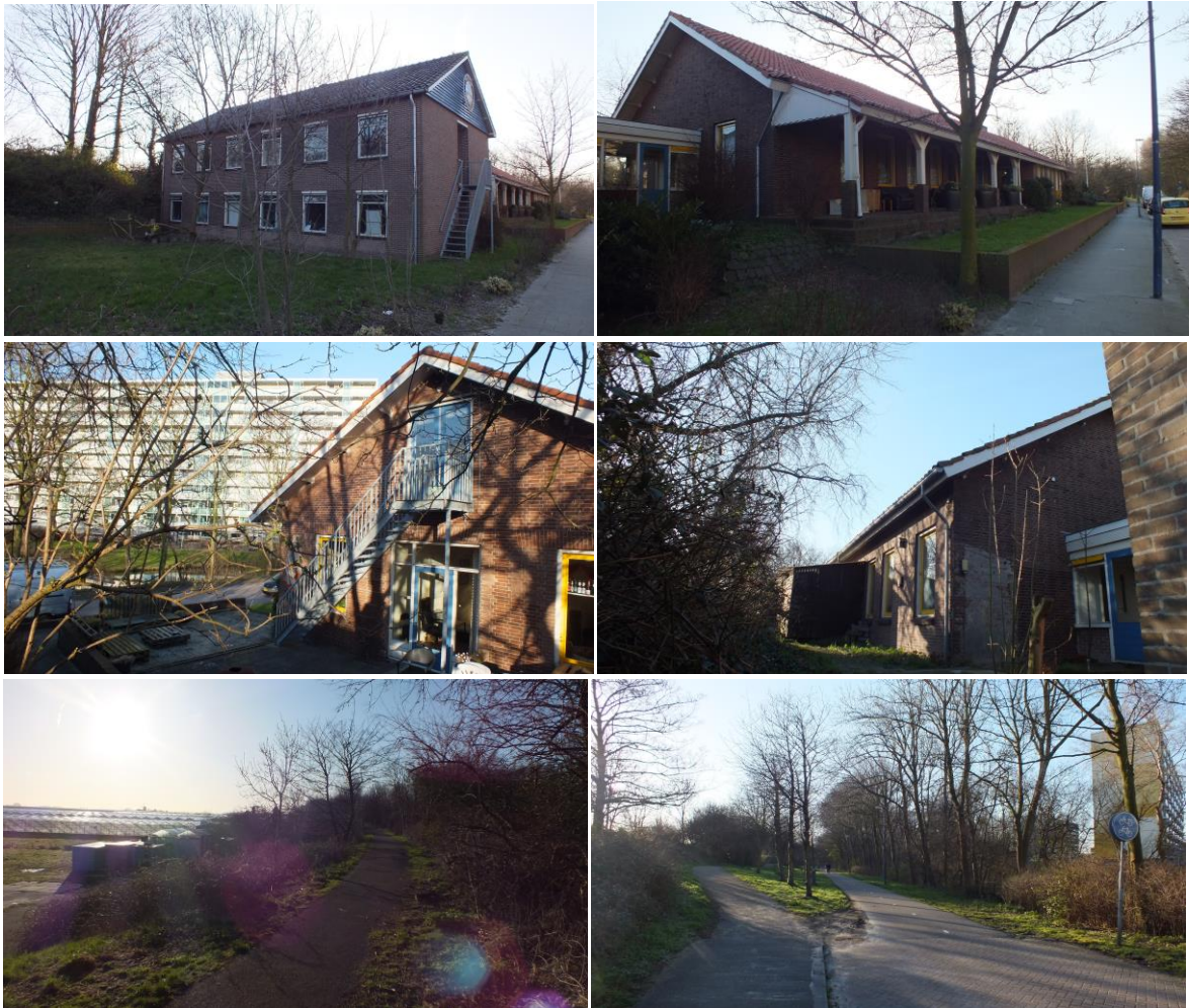
Figuur 3.2. Impressie van het August Reitsmahuis. Linksboven: de aanbouw uit de jaren '60. Rechtsboven: de voormalige dienstkantine uit de Tweede Wereldoorlog. Middelste foto's: de voormalige dienstkantine aan de oost en noordzijde. Linksonder: de Nieuwlandsedijk (Natura 2000) met het achterliggende kasgebied. Rechtsonder: de Nieuwlandsedijk (NNN).
