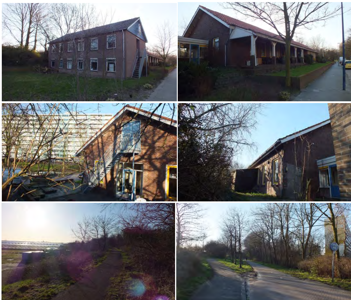
Figuur 3.2. Foto impressie August Reitsmahuis. Linksboven: de aanbouw uit de jaren '60. Rechtsboven: de voormalige dienstkantine uit de Tweede Wereldoorlog. Middelste foto's: de voormalige dienstkantine aan de oost en noordzijde. Linksonder: de Nieuwlandsedijk met het achterliggende kasgebied. Rechtsonder: de Nieuwlandsedijk (Natura 2000-gebied).
