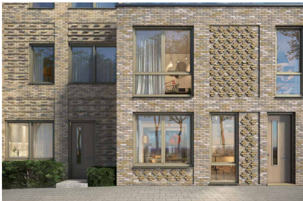
Referentie tactiliteit in metselwerk
