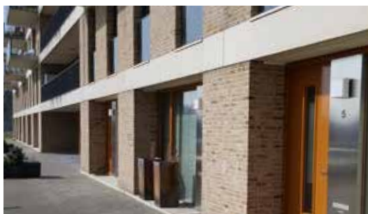
De plint heeft een open karakter met woningen
