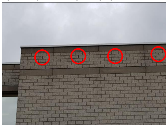
Figuur 12. Open stootvoegen, toegang voor vleermuizen
