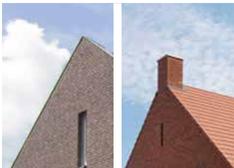
Eenvoudige dakranden en gevelvlakken.
