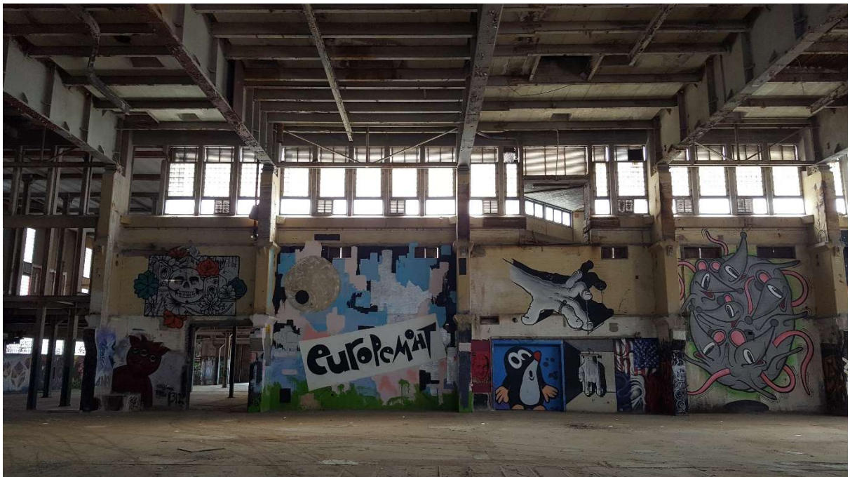
Figuur C.4 Binnenaanzicht – deel C – zuidgevel
