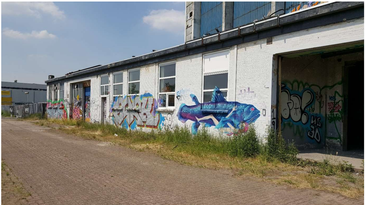
Figuur C.10 Buitenaanzicht – deel B – zuidgevel
