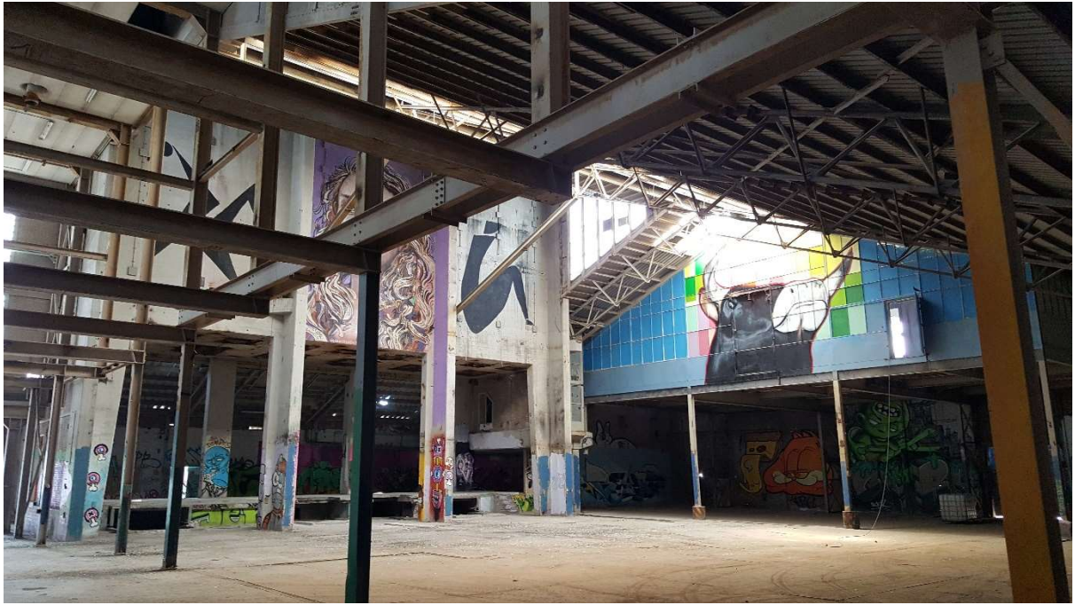
Figuur C.7 Binnenaanzicht – deel B – westgevel
