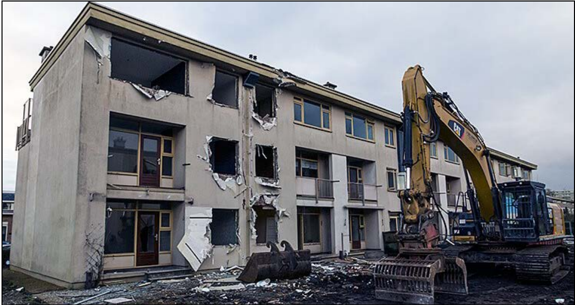
Afbeelding 3: Sloop van de panden binnen het plangebied (2016).
