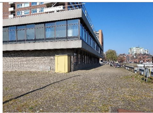
Foto 4: Doorgang vanaf de parkeerplaatsen (Boerengatkade). Aan de oostzijde (rechts) bevindt zich een kanaal.
