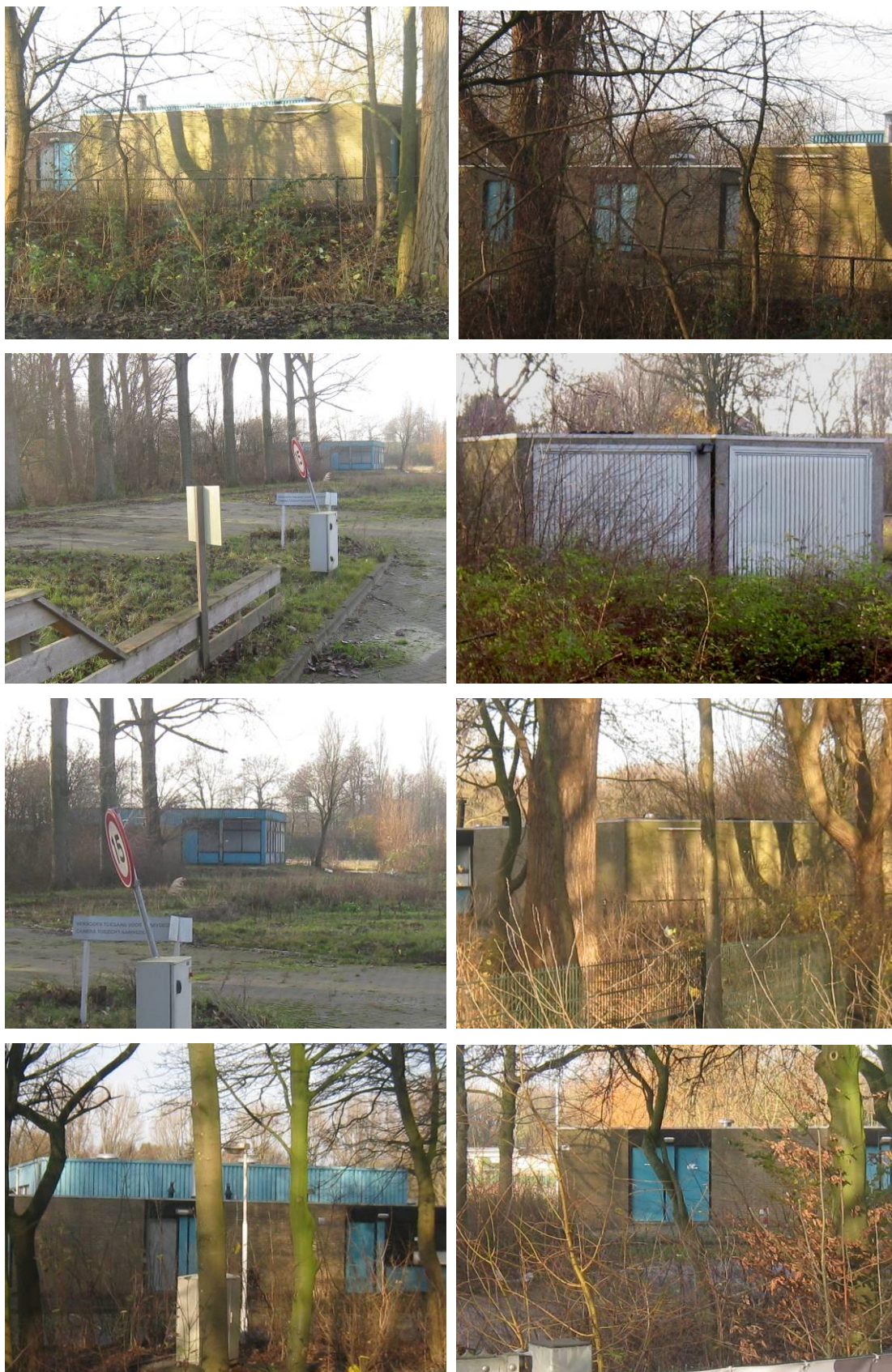
Figuur 3. Opstallen in het plangebied van Lage Weide te Rotterdam.
