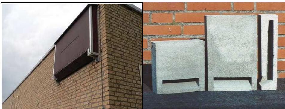
Figuur 5.3 Links te realiseren grote (kraam) kast voor gebouwbewonende vleermuizen (bron en specificaties: www.vleermuis.net , © Erik Korsten). Rechts een vleermuisensteen die in de gevel van een nieuw gebouw ingemetseld kan worden (bron: www.hasselfeldt-naturschutz.de )
