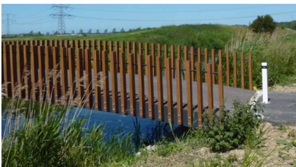
Foto hoofdstructuurbrug in Oranjevouterpolder
