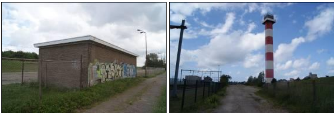
figuur 9 en 10: resp. (vermoedelijk) transformatorhuisje en toren
