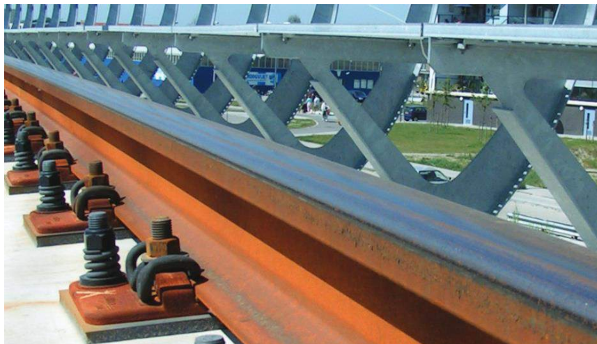
Figuur 4 Viaduct Oosterheemlijn (RandstadRail), met FC104 pad (zichtbaar) en FC9 (onder de rail). (foto: website Alom)
