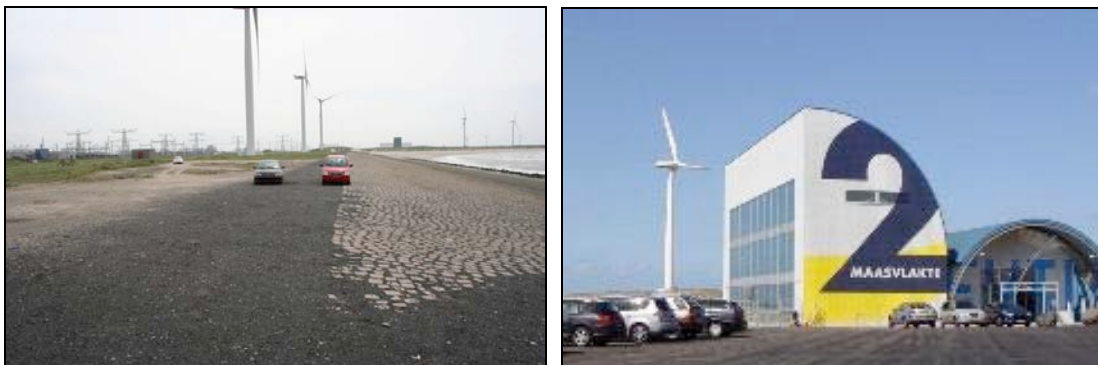
Afbeelding 2: Links de oude situatie van Slag Dobbelsteen als zeewering van Maasvlakte 1. Rechts het informatiecentrum FutureLand; één van de tijdelijke voorzieningen op deze locatie.
