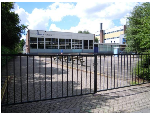
Figuur 1 Te slopen gebouw
