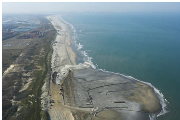
Verbreding Delflandse kust in uitvoering ten noorden van Ter Heijde vanuit het noorden
