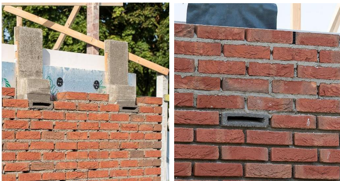
Figuur 19 en 20: inbouwkast (tijdens inbouw en eindresultaat)
