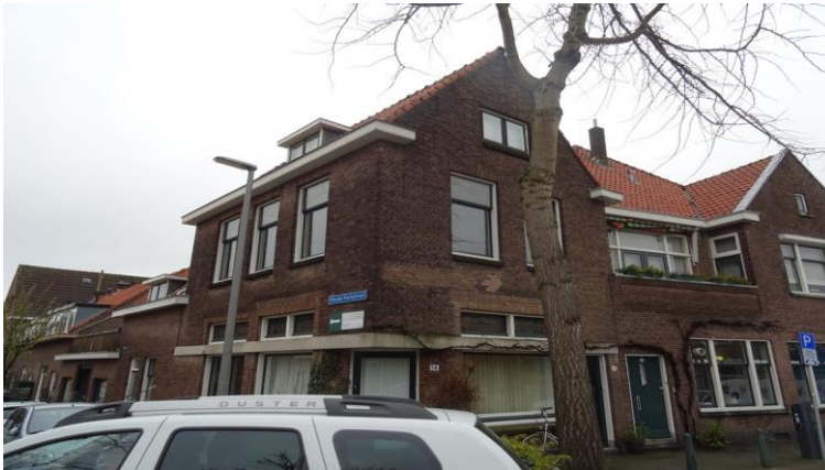
Ontwikkellocatie 16: Overhellende gevelpannen bieden toegang tot de bebouwing voor vleermuizen, huismus en gierzwaluw. Foto: K.J. van Veen | Ecoresult B.V.
