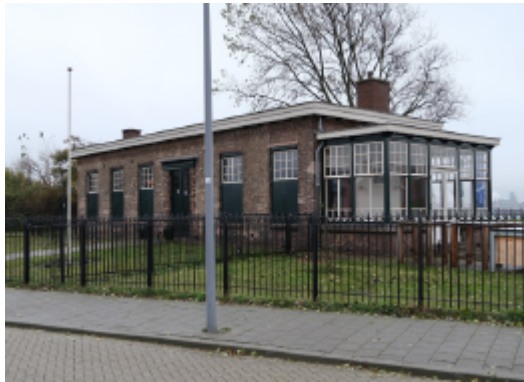
Stationsweg bij 80: liftgebouw annex garagewerkplaats uit 1943 door de Duitse bezetter gebouwd in zakelijke bouwtrant, deel uitmakend van het fort-ensemble.
