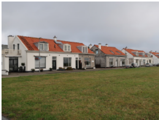
Koningin Emmaboulevard: loopbrug met aanleghoofd als karakteristiek en inmiddels zeldzaam voorbeeld van een dergelijke aanlegsteiger.
