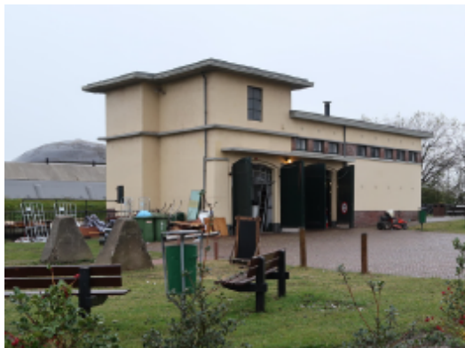
Stationsweg 84: geschakelde commandants- en officierswoningen uit 1884 naar ontwerp in sober eclectische stijl van de Genie, deel uitmakend van het fort-ensemble.
