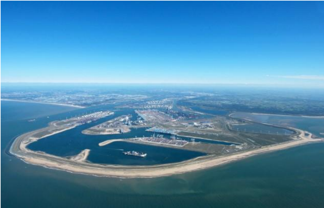
Figuur 2-1 Luchtfoto Maasvlakte 2, oktober 2016
