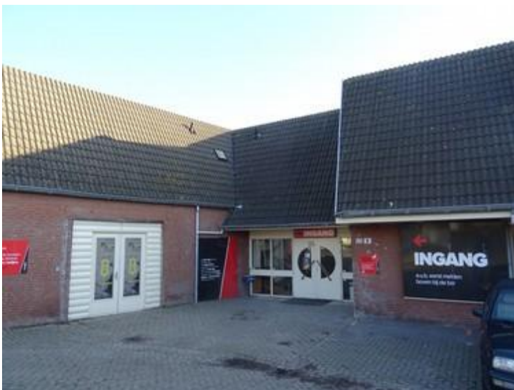
Ontwikkellocatie 2. Ruimten onder het dak en in de lichtspouw bieden potenties voor Huismus, Gierzwaluw en Gebouwbewonende vleermuizen. Foto: K. van Veen | Ecoresult B.V.
