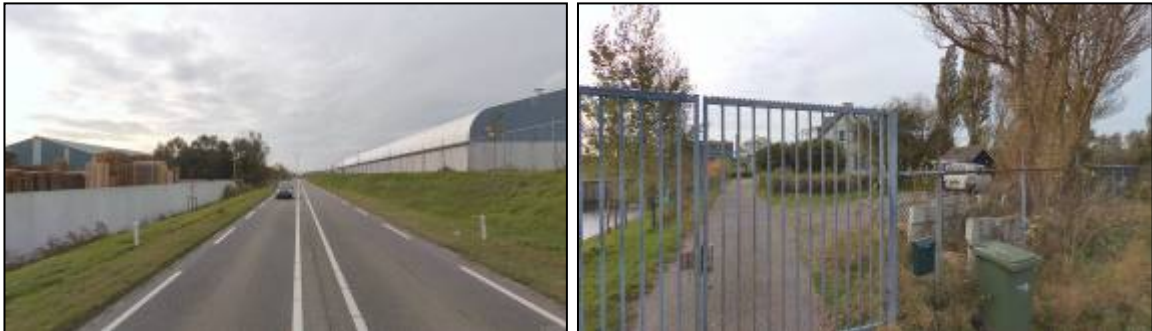
Figuur 6 en 7: resp. bedrijfsgebouwen langs Hoekse Baan en gemaalwoning
