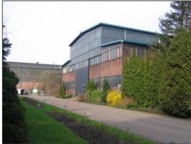
Zuidelijke gevel van gebouw C.
