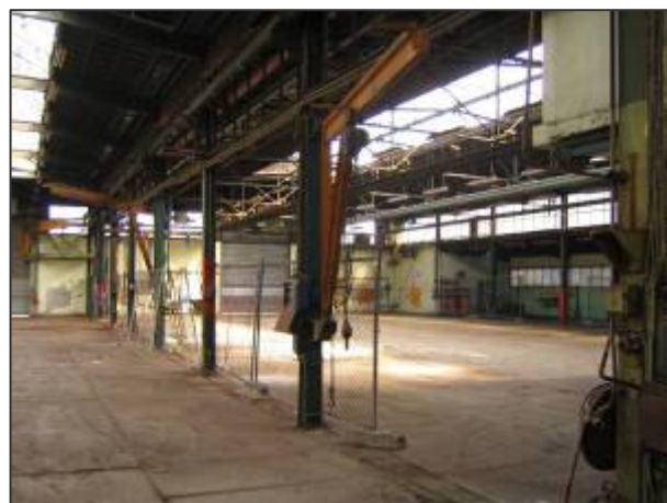
Interieur gebouw D, in noordelijke richting.
