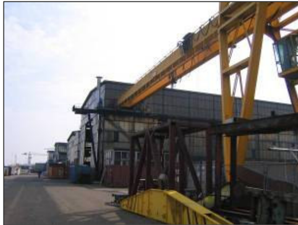
Noordwestelijke gevelwand van gebouw B.
