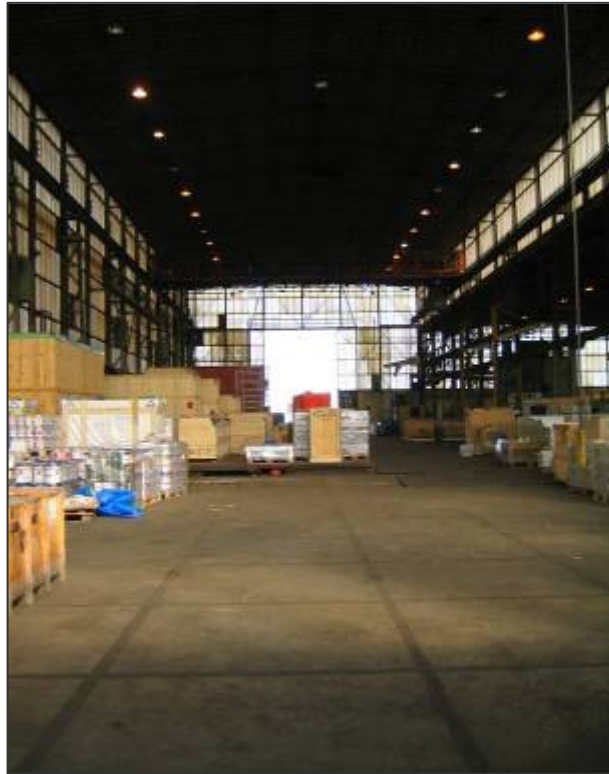
Interieur van gebouw B richting het noorden gefotografeerd. De opzet van de twee bouwvolumes in een hoger en lager gedeelte levert extra daglichttoetreding op.
