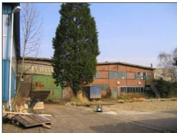
Zuidgevel gebouw D.
