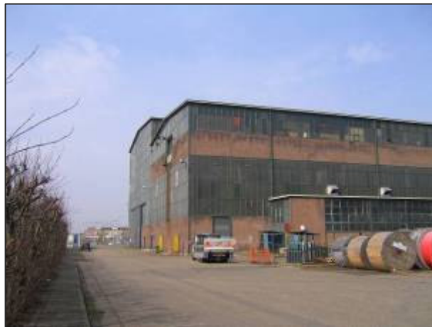
Oost-/zuidelijke gevelwand met een strook laagbouw.
