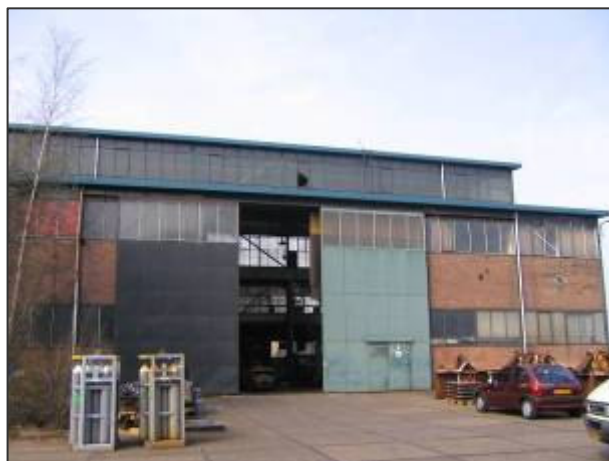
Detail van de oostelijke gevelwand van gebouw C.
