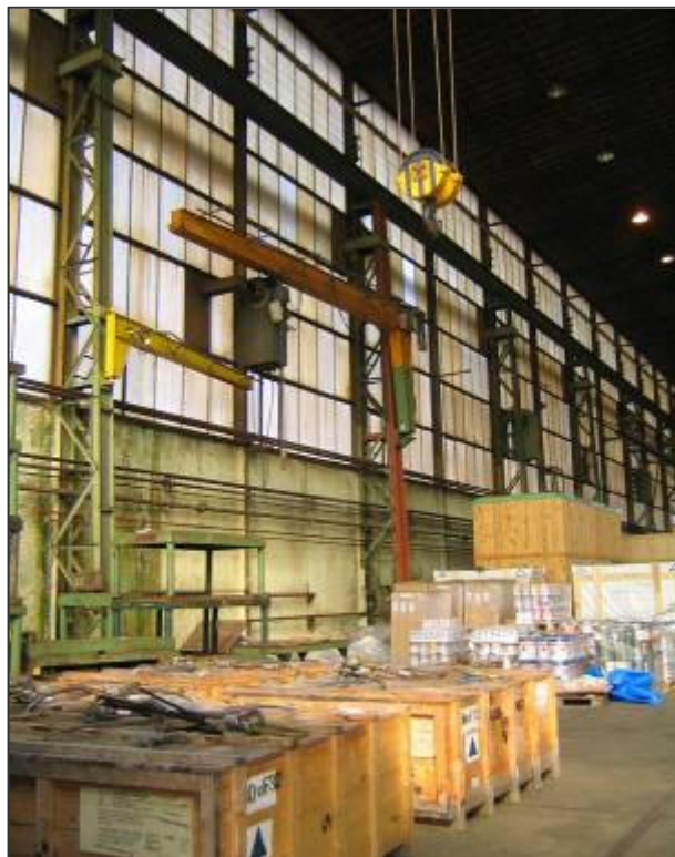
Detail westelijke zijgevel. De kraanbanen rusten op eenvoudige stalen I-profielen, versterkt middels schoren en dwarsverbanden.
