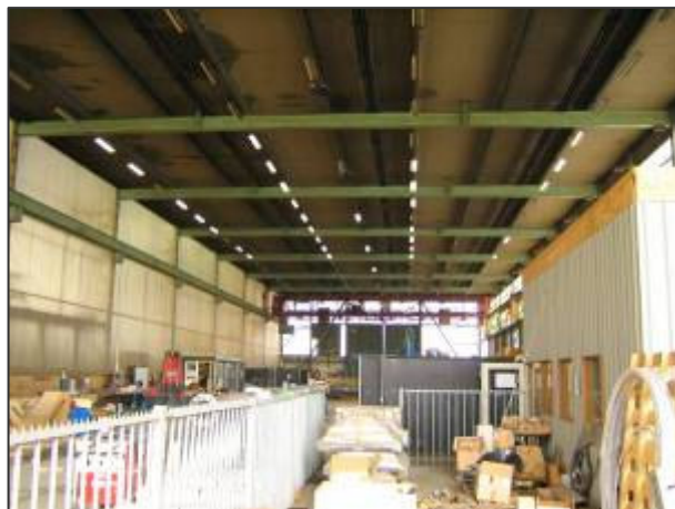
Interieur begane grond van het lagere gedeelte van gebouw A, gezien richting rivierzijde.
