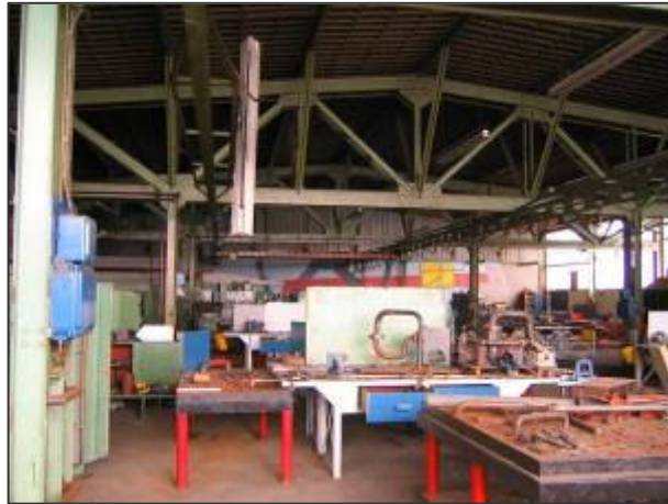
Interieur van de bedrijfsschool op de eerste verdieping van het oostelijke gedeelte van gebouw A. Bij de opbouw van de dakspanten die de bimsbetonplaten dragen is op enkele plaatsen gebruik gemaakt van geklonken verbindingen. Het overgrote deel is voorzien van verbindingen middels moeren.
