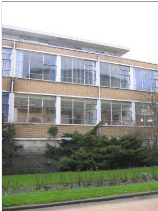
Detail noordgevel. De lange zijden kennen een regelmatige indeling van betonnen kolommen, glazen vliesgevels en met gele baksteen ingevulde stroken.
