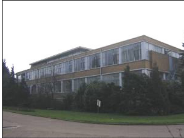
Noordwestelijke gevel van het kantoor.
