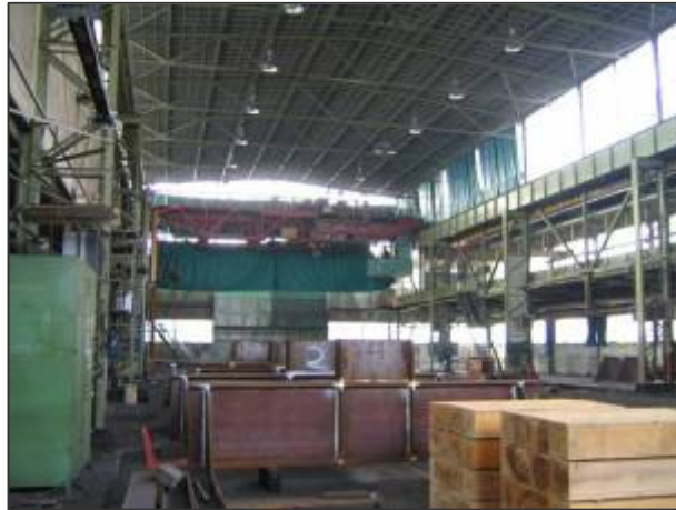
Overzicht interieur gebouw C, gezien in zuidelijke richting. Het verhoogde middengedeelte met glasinfilling zorgt voor extra lichtinval.
