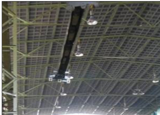
Detail dakconstructie gebouw C. Ook deze loods is voorzien van een stalen spantconstructie die de bimsbetonplaten dragen.
