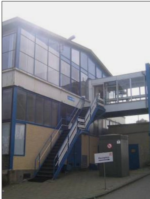
Westgevel van gebouw 2, met zicht op de loopbrug die dit gebouw en het kantoor (gebouw 1) met elkaar verbindt.
