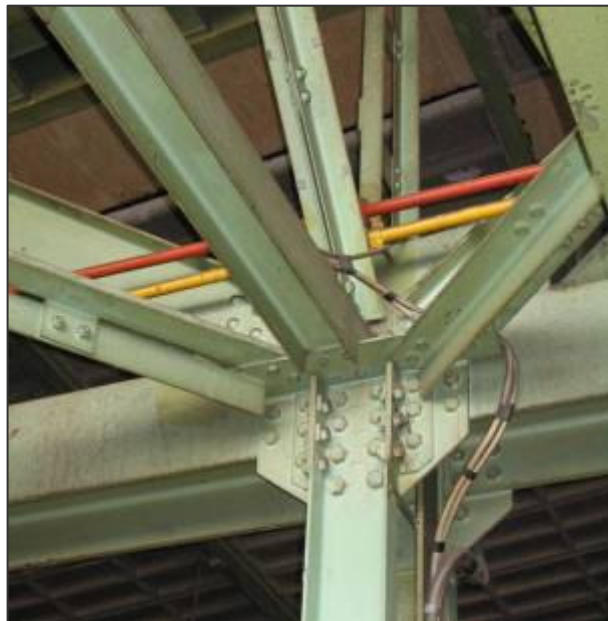
Samenkomst van kolom, liggers en dakspant, uitgevoerd in staal met geklonken en moerverbindingen.
