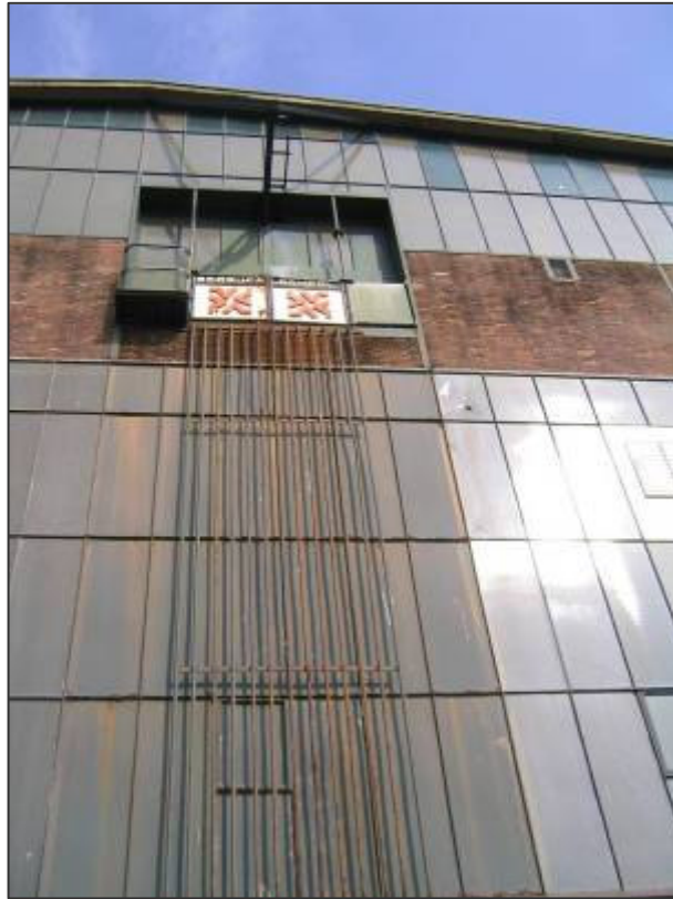
Detail van hijsblok en laaddeuren op de eerste verdieping waar de bedrijfsschool was gevestigd.
