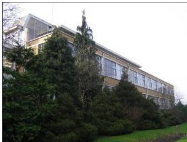
Noordoostelijke gevel van het kantoorgebouw.
