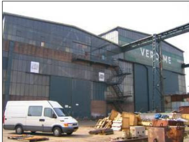
Noordelijke gevelwand gebouw A.
