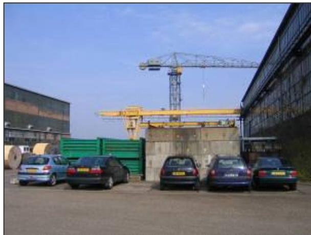
Zicht op de opslagplaats tussen gebouw A (links) en gebouw B (rechts).
