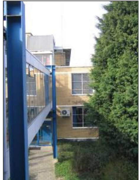
Oostelijke gevel gezien vanaf de loopbrug.
