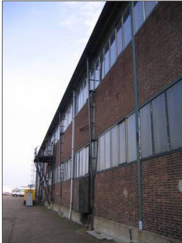
Detail van de westelijke gevelwand gebouw C. in de twee zijbeuken van het gebouw zijn verdiepingen aangebracht, hetgeen aan de buitenzijde valt af te lezen door het gebruik van twee lagen baksteen. De uitkragende stalen stijlen dragen om-en-om de dakgoot.
