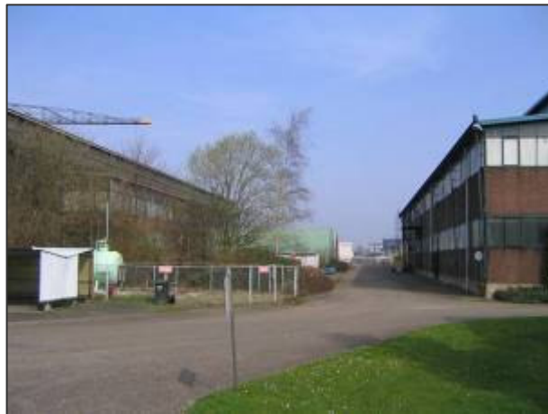
Opslagplaats tussen gebouw B (links) en gebouw C (rechts), gezien in noordelijke richting.
