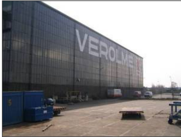
Westelijke gevelwand, gezien richting het zuiden
