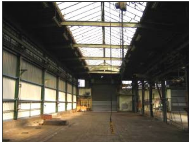
Foto in noordelijke richting van het later aangebrachte bouwdeel om de oorspronkelijke loods (rechtergedeelte) en de in 1948 (en later vervangen door een nieuwe) gebouwde loods met elkaar te verbinden.
