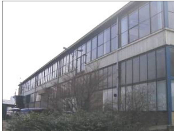
Noordelijke gevel van gebouw 2. Aan het uiteinde van de gevel is de buitentrap geplaatst voor toegang tot de verdieping.
