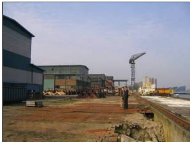
Noordelijke gevelwand van het Verolme-terrein, met als tweede loods van links gebouw C.
