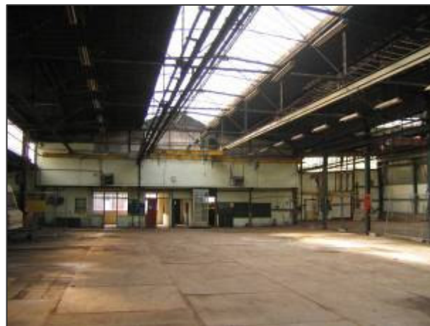
Interieur gebouw D, in zuidelijke richting met zicht op kantoorgedeelte. De loods is in het midden voorzien van een lichtstrook in het dak ten behoeve van daglichttoetreding.
