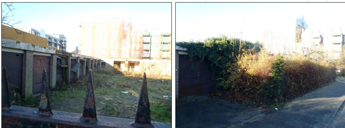
Figuur 1: impressie plangebied met vervallen bebouwing (links) en begroeide gevel met beplantingshaag (rechts)
