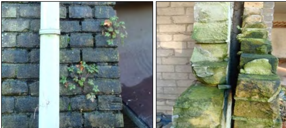
Figuur 2: natte muur met Robertskruid (links)tochtige spouw ongeschikt voor vleermuizen (rechts)
