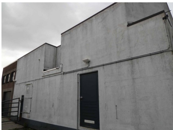
Figuur 24 Achterzijde loods
