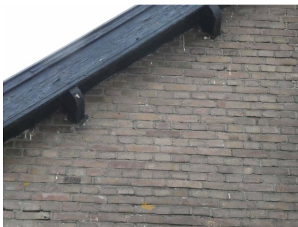
Figuur 23 Detail daktrim
