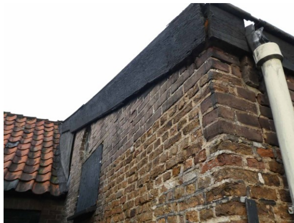
Figuur 17 Daktrim zijgevel
