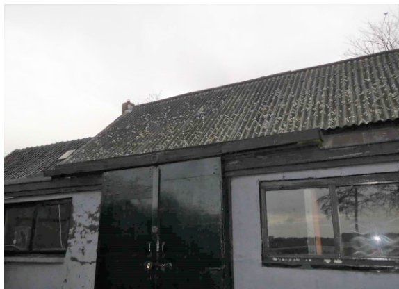
Figuur 19 Zijgevel dak schuur
