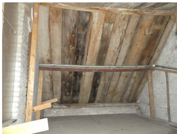
Figuur 16 Dakconstructie binnenzijde pand
