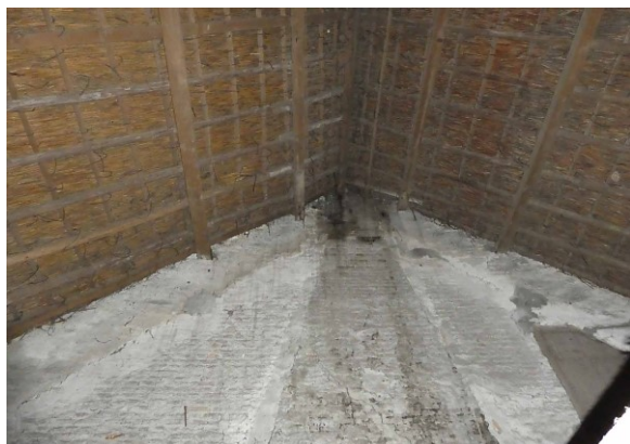
Figuur 20 Binnenzijde dak schuur
