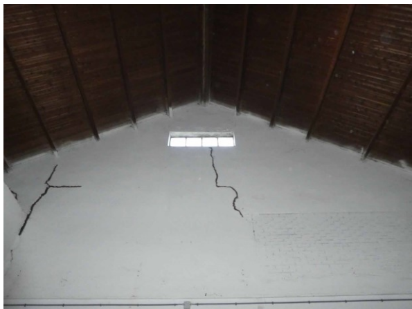
Figuur 26 Binnenzijde dakconstructie loods
