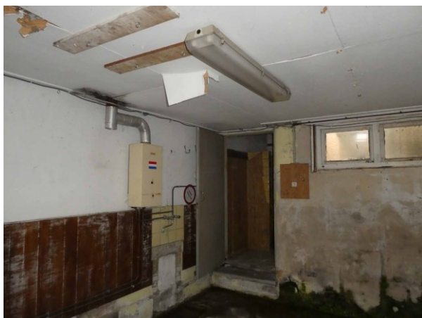
Figuur 15 Binnenzijde pand
