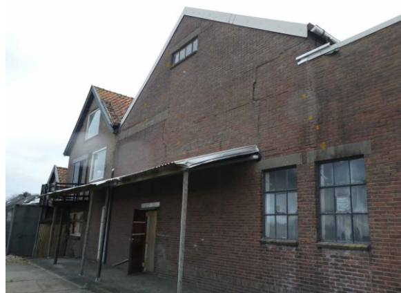
Figuur 25 Achterzijde loods
