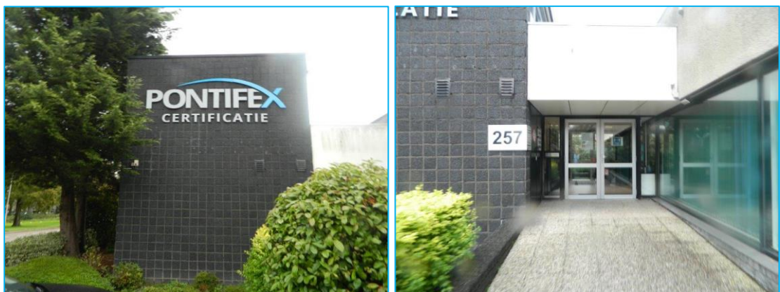
Foto's: Indrukken plangebied. Bedrijfsgebouw.
