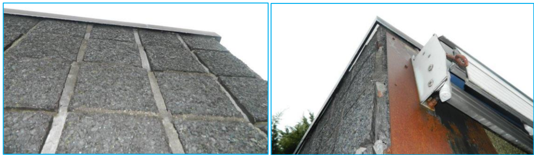
Foto's: Goed te onderzoeken (dak)constructie.
