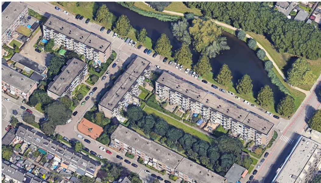
Situatie | Bestaand, sloop van 94 portiek woningen
