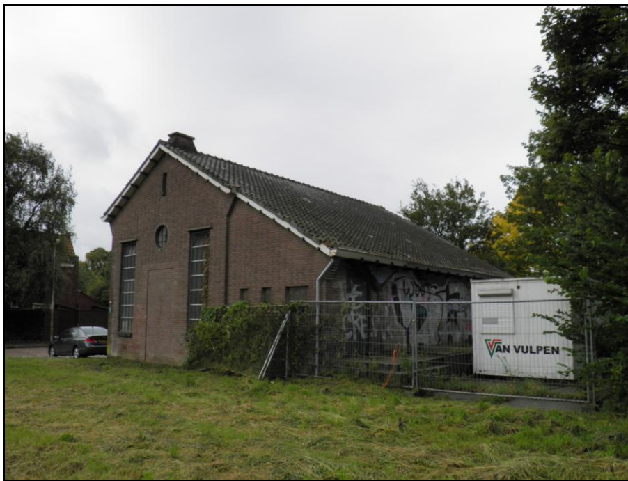
Figuur 3. De achterzijde van het gemaal met rechts de bomen en struiken die zullen verdwijnen.
