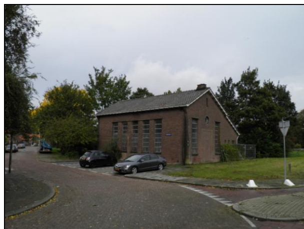
Figuur 2. Gemaal P01 aan de Poesiastraat dat vervangen zal worden.
