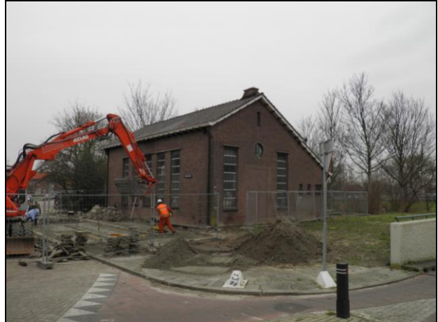
Figuur 4. Het gemaal langs de Poesiastraat in Ridderkerk.
