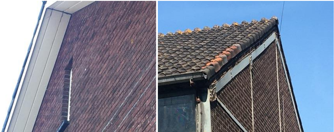
Detailfoto's van het plangebied. Vleermuizen kunnen de spouw betreden via kieren tussen de gevel en de overstek en tussen de bakstenen en de gevelpannen.
