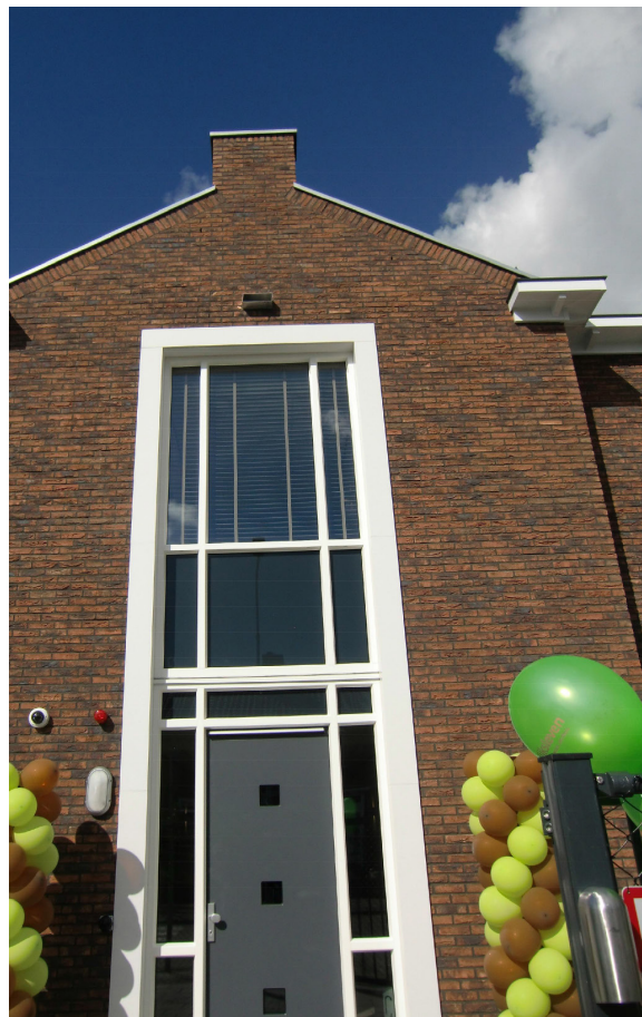
Voorbeeld gerealiseerd woonzorgcomplex
